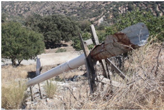
Εικόνα 8 – Αυτοσχέδια κατασκευή για ρίψη οικοδομικών απορριμμάτων σε χαμηλότερο ύψος
