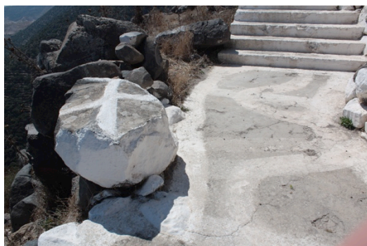
Εικόνα 6 – Οριοθέτηση ‘πεζοδρομίου’ σε όλα τα επίπεδα
